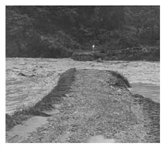
中津川地内の道路崩壊
