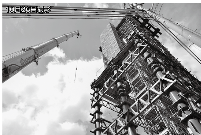
橋梁へ荷重をかけずに施工を行うための、部材を吊るすワイヤー用のタワーを仮設中
