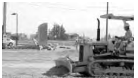
自社のブルドーザーを持ち込んでの大掛かりなボランティア活動となった
