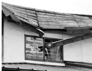
屋根は原形を失い、トタンはすっかりはがれている。数年前、この屋根のトタンの一部が飛び、付近に駐車していた車に落ち、損害を与えた事故が発生している。もし人だったら…。現在は、危険防止の養生が施されている。
