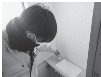
給水装置工事の検査
