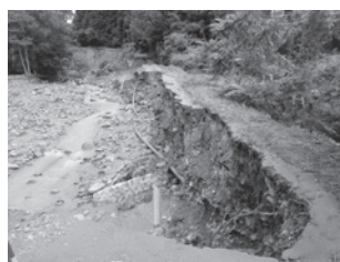
▲令和4年8月豪雨で破損した導水管(萩生大平)
