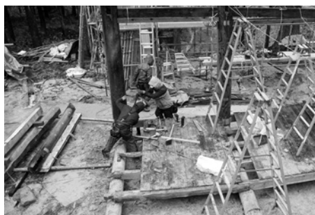
▲解体工事の様子（令和4年11月～12月）（大工手塚建築提供）
