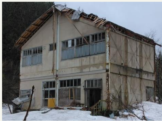
旧中津川小中学校岳谷分校(岩倉地内) 建設1948年 経過年数73年 延床面積199 m 2
