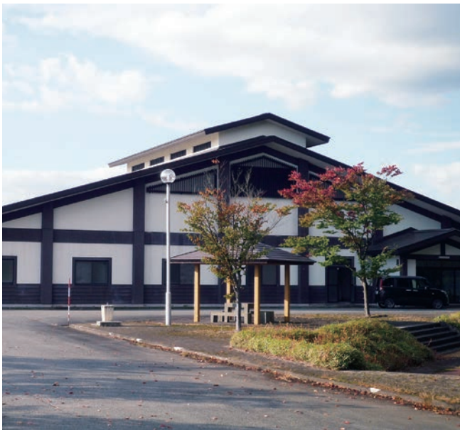
20年以上経過の下水道施設（萩生）
