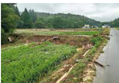
クランク状態の台沢排水路
