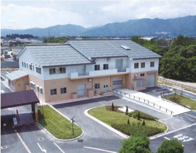
汚泥再生処理センター 完成 (長井クリーンセンター内)
