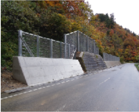
松枝岐線改良工事完成
